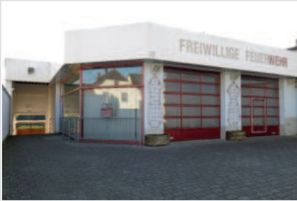
Umbau des alten Feuerwehrhauses zum Dorfgemeinschaftshaus!
